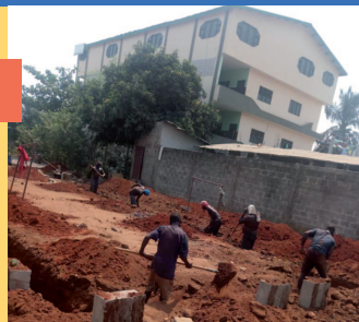
Début des travaux pour le dispensaire mi-février
